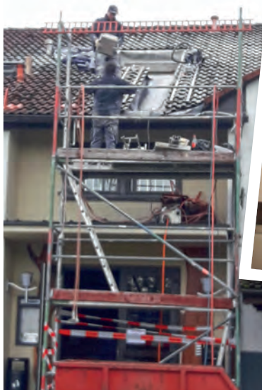
Aussägen der 30cm dicken Betonplatte am Dach des Sportheims
