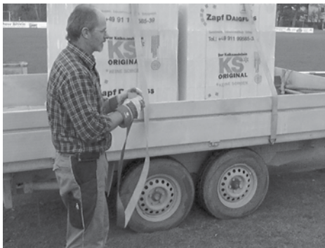
Anlieferung der Baumaterialien
