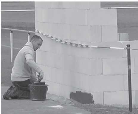
Isolierung gegen Feuchtigkeit
