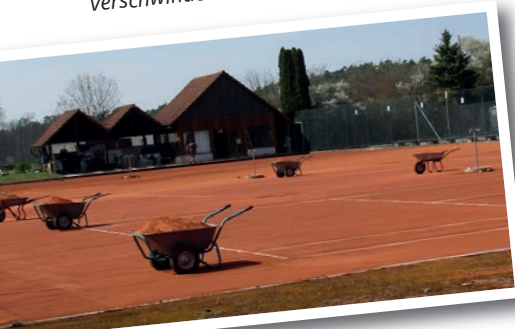
und hier werden die letzten fünf Schubkarren Ziegelmehl auf die Plätze verteilt
