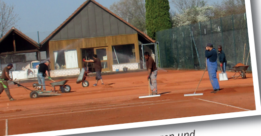
Der alte Belag wird abgetragen und im Altmaterial-Container deponiert
